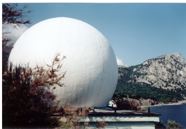
Рис. 3. Радиотелескоп на волны 10 и 12 см в радиопрозрачном куполе
